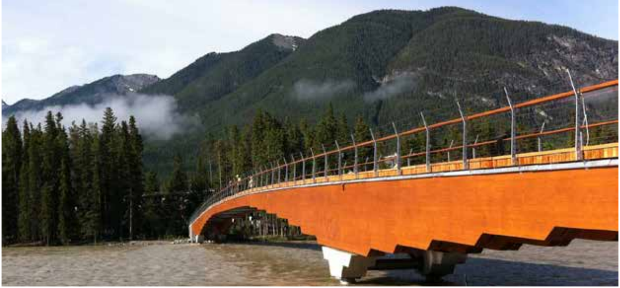
Pont piétonnier et traverse de services publics de Bow River – Prix d'excellence 2014
